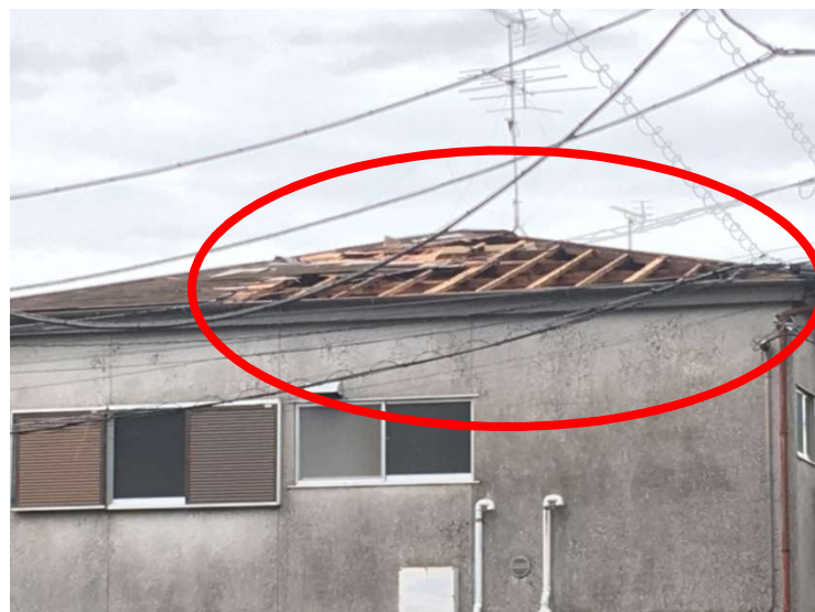
↑ アパートの屋根が強風で飛ばされています。
