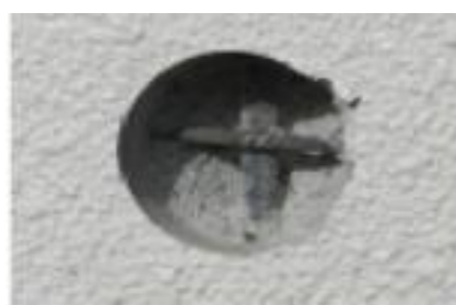
【コンクリート削り取り作業後】
