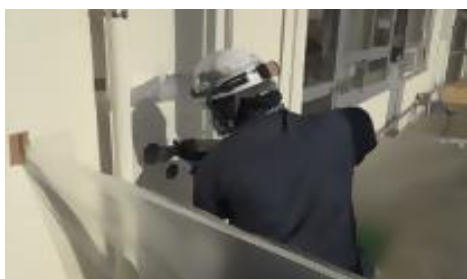
【コンクリートの削り取り作業】
